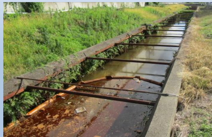
オイルフェンスにより、下流に油類が流れ出るのを防いでいる様子
