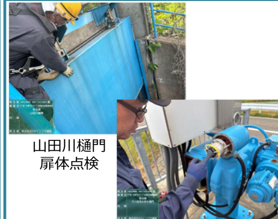
下八枚雨水排水樋門 開閉機点検
