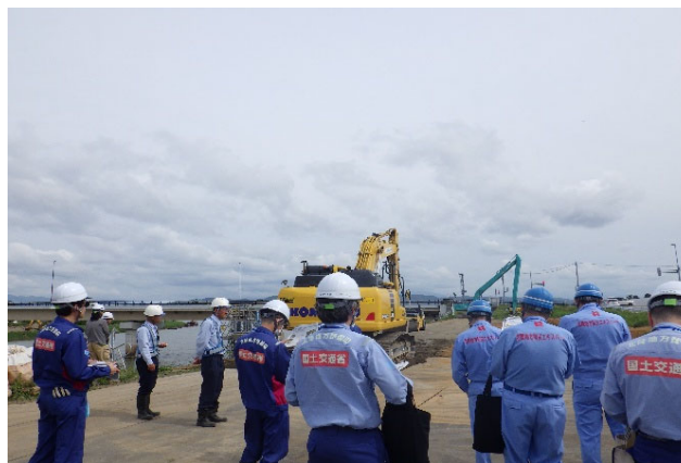
②臼井地区堤防緊急復旧状況
