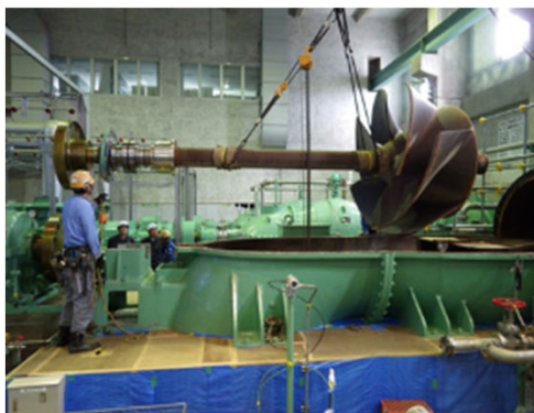
西川排水機場 4号主ポンプ・主原動機分解整備
