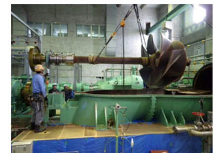
西川排水機場 4号主ポンプ・主原動機分解整備
