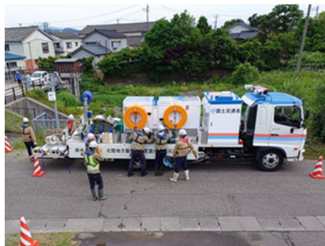
排水ポンプ車の設営
