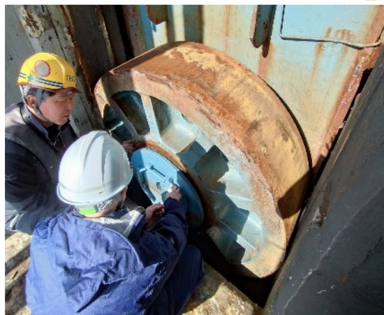
新潟大堰 主ゲート・主ローラ故障時の緊急復旧
