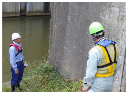
護岸等の点検
