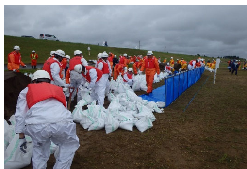
改良積み土のう工 訓練
