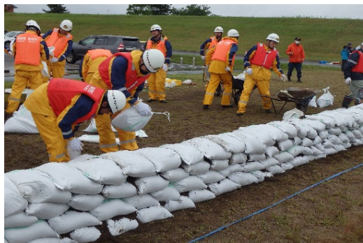
積み土のう工 訓練
