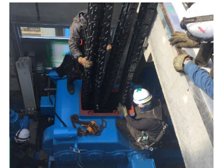
新潟大堰 閘門下流ゲート開閉機更新
