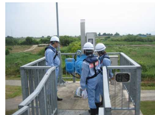
子成場雨水排水樋門点検（直轄管理）
