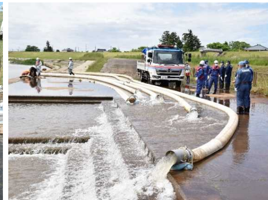
排水ポンプ車訓練
