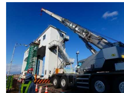
西川水門設備更新工事
