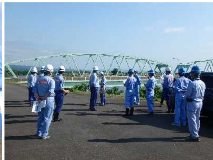
④小須戸橋左岸
