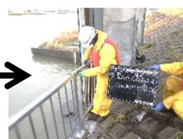
樋管門柱部の転落防止柵修繕
