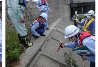
亀鶴橋取付護岸
