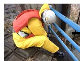
樋管門柱部の転落防止柵修繕
