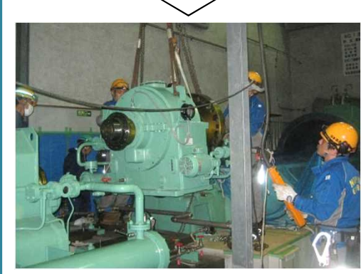
排水ポンプ分解整備
