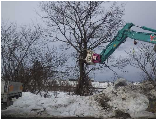
河道内樹木の伐採状況
