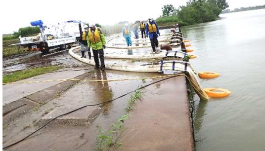
排水ポンプ車の設営
