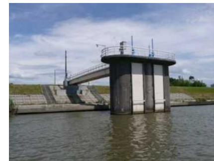
新潟市上水道取水塔
