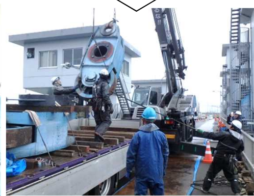
中ノ口川水門 主ローラ補修
