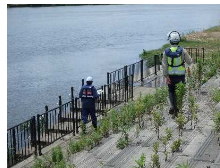
三条市民憩いの広場点検
