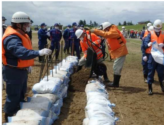
積み土のう工
