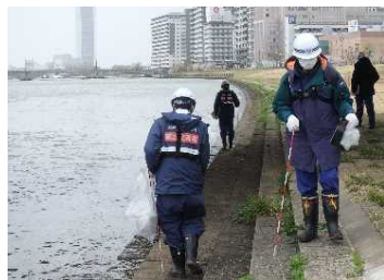
護岸等の点検
