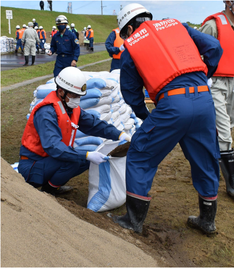
●積み土のうエー土のう製作
