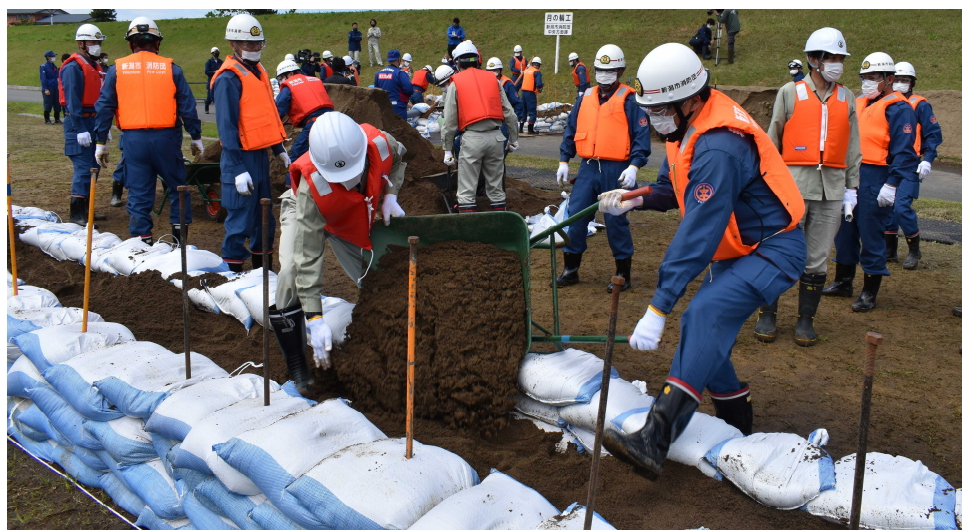
●水防訓練の様子（積み土のう工）
