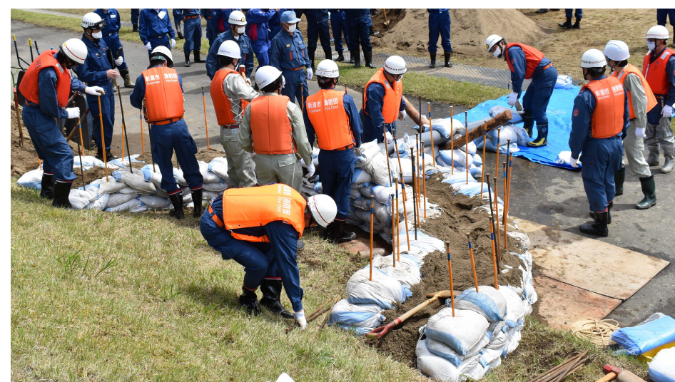
●水防訓練の様子（月の輪工）
