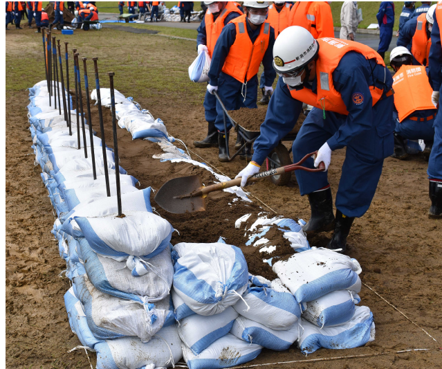
●積み土のう工
