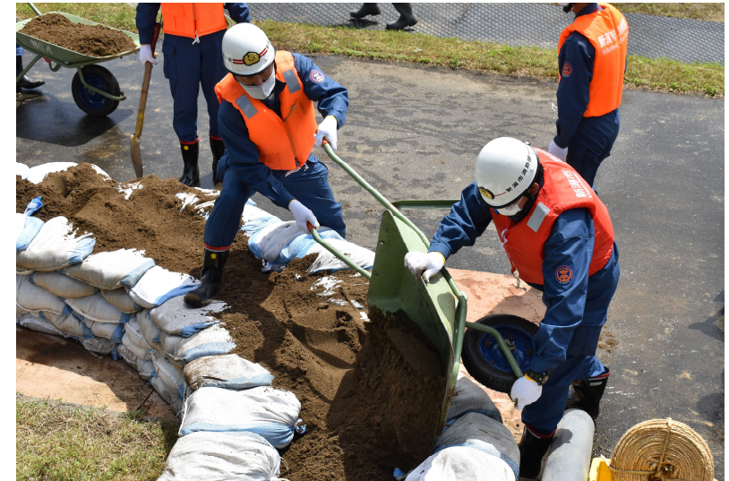
●月の輪工一中詰め土砂充填
