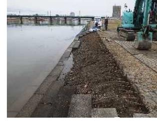
階段護岸補修作業状況
