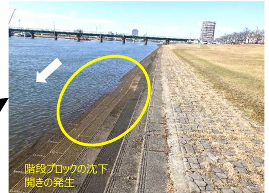
階段ブロックの沈下
