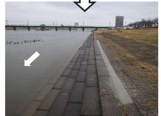
階段護岸補修作業完了後
