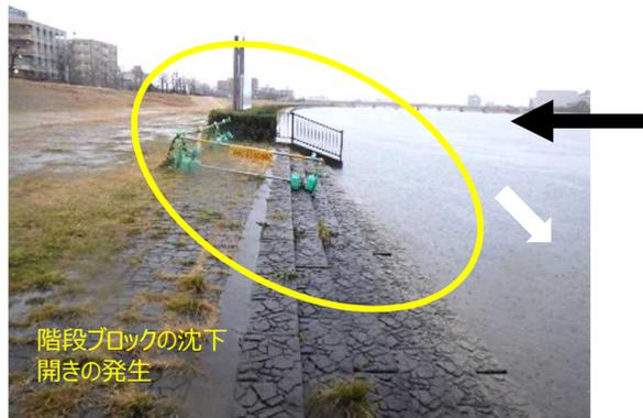
階段ブロックの沈下
