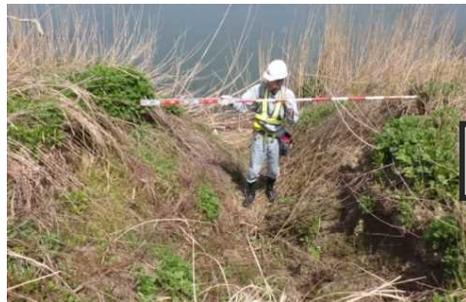
信濃川右岸 河岸土砂崩壊
