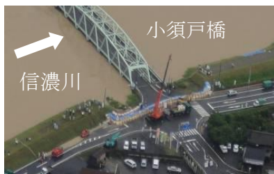
水防活動の状況 (H23.7出水)
