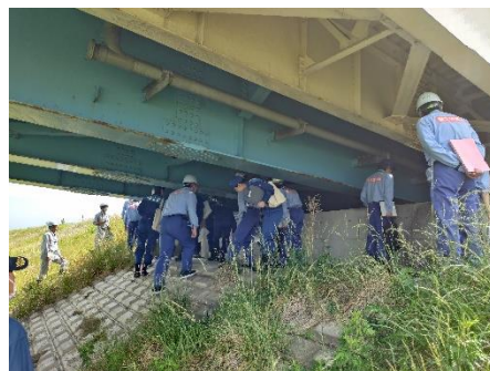
特殊堤の状況を確認 【信濃川大橋】
