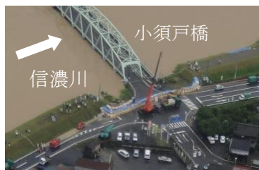
水防活動の状況 (H23.7出水)
