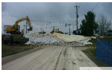
水防活動の状況 (H16.7出水)
