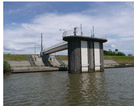
信濃川取水塔(新潟市水道局)
