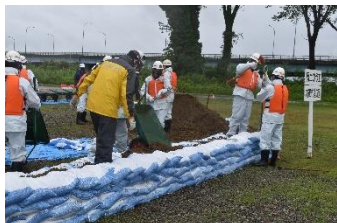
積み土のう工
