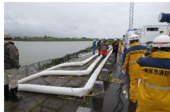
排水ポンプ車訓練
