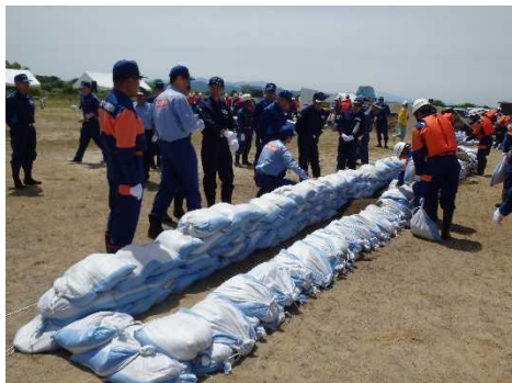
水防工法「積み土のう工」
