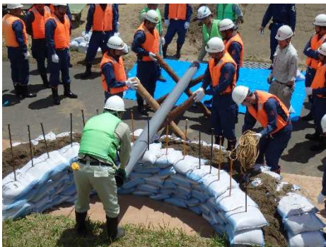
水防工法「月の輪工」
