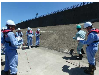
特殊堤の点検
