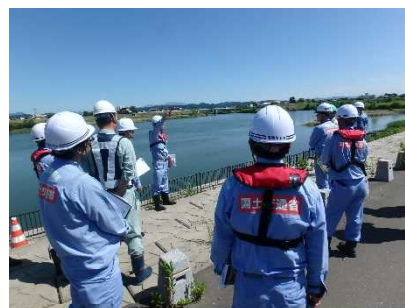
河道内の堆積土砂の確認
