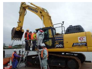
平成30年度活動状況 (ICT浚渫工事勉強会)
