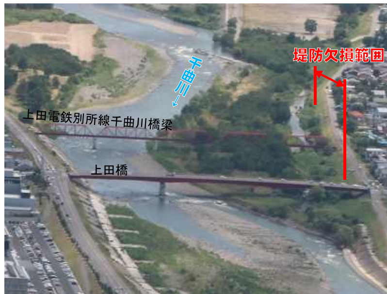
図-1 台風第19号出水前の状況
