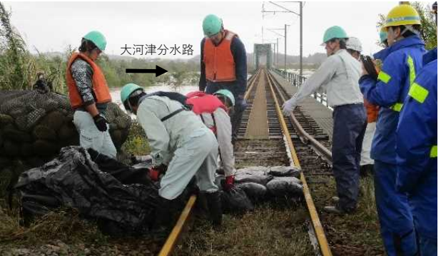
(右岸) 土のう積 作業状況 (燕市)
