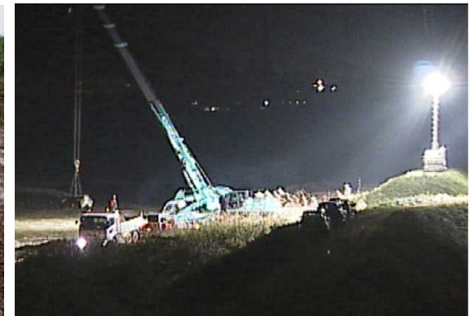
24時間体制で応急復旧作業を実施
