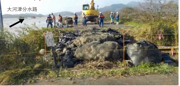
(右岸) 土のう積 作業完了 (燕市)
