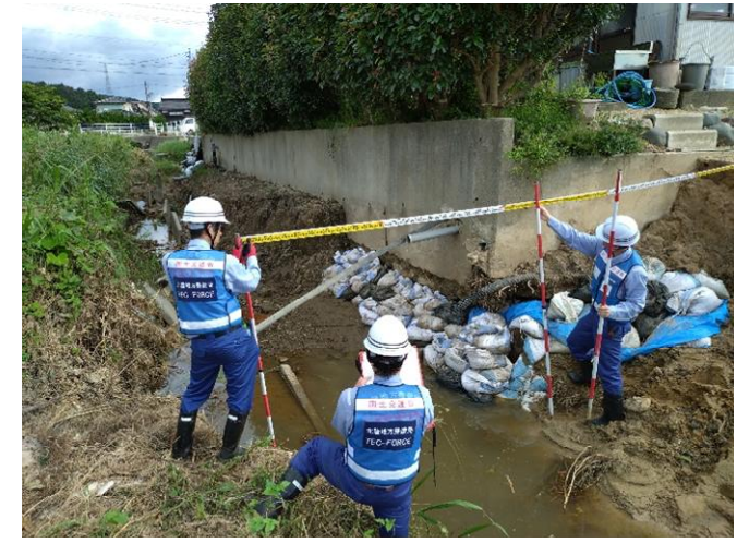
被災状況調査状況
