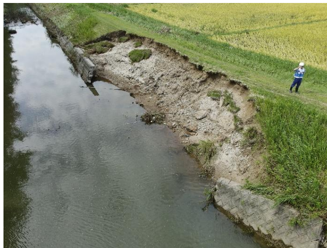
ドローンによる空撮状況
