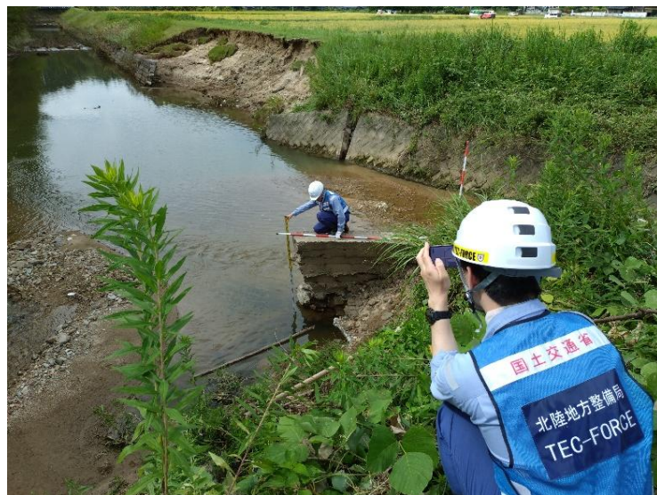
被災状況調査状況
