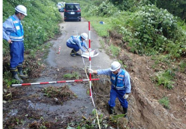
被災状況調査状況
