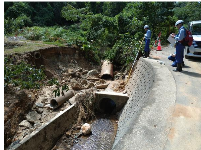
被災状況調査状況
