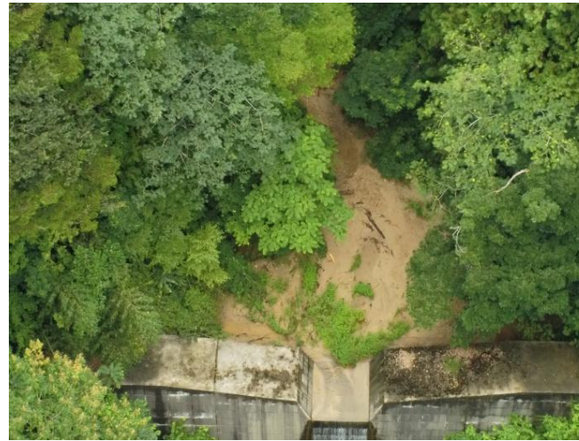
ドローンによる空撮状況
