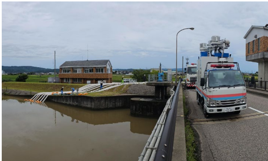
▼排水作業の状況（潮止水門）
