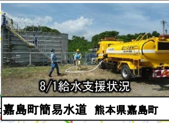
8/1給水支援状況 嘉島町簡易水道 熊本県嘉島町
