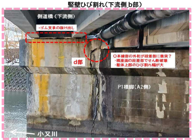
【写真⑧】P1橋脚 A2側正面 堅壁ひび割れ(下流側_b部)
