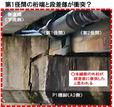
【写真⑦】P1橋脚 A2側正面(下流側_d部拡大) 第1径間の桁端と段差部が衝突?
