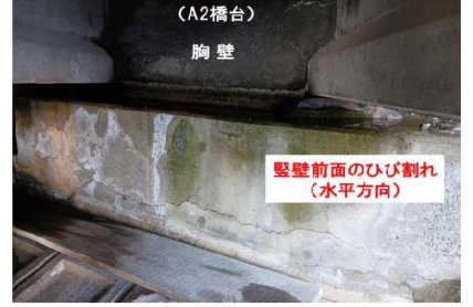
【写真⑪】A2橋台 堅壁のひび割れ(水平)
