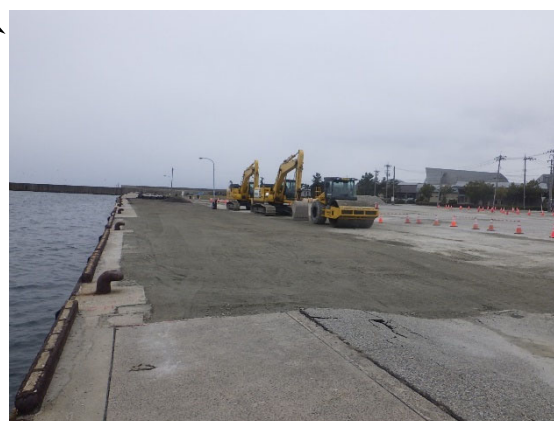
応急復旧完了(3月4日)
