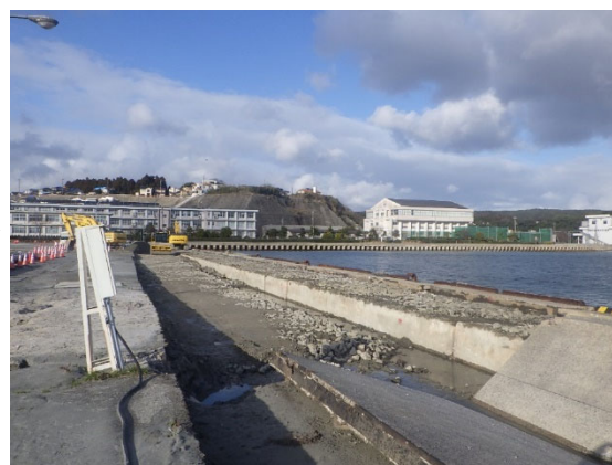
応急復旧工事(コンクリート版撤去)
