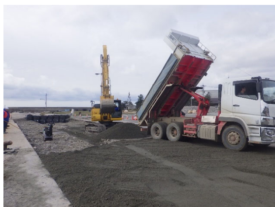
応急復旧工事(碎石敷均し・転圧)
