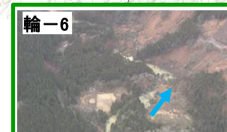
輪-6 鈴屋川(町野町寺山) 【監視中】 ・大きな変状は認められない
