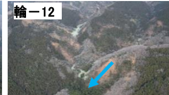
輪-12 【監視中】 ・大きな変状は認められない
