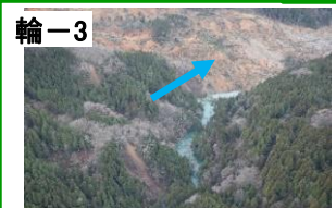
輪-3 紅葉川[猿谷](市ノ瀬町) 【応急対策済】 ・下流大型土のう工完成 ・仮排水路完成 【監視中】 ・大きな変状は認められない
