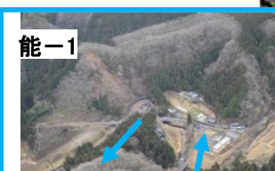
能-1 山田川(宮地) 【応急対策済】 ・掘削により通水断面確保
