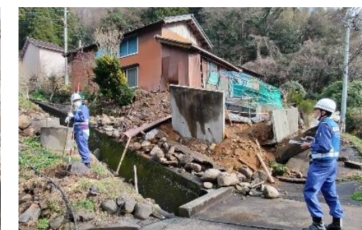
調査状況(輪島市)
