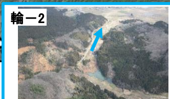
輪-2 金蔵川[田長川](町野町川西) 【応急対策済】 ・掘削により通水断面の確保
