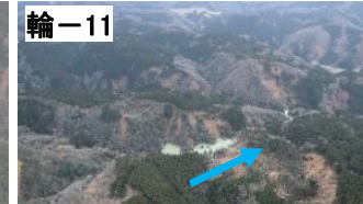
輪-11 鈴屋川[牛尾川](町野町牛尾) 【応急対策済】 ・下流大型土のう工完成 ・ブロック堰堤完成 【監視中】 ・大きな変状は認められない
