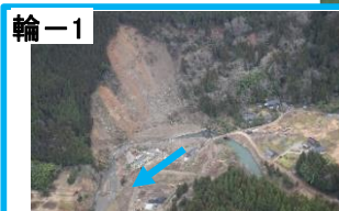
輪-1 河原田川(熊野町) 【応急対策済】 ・掘削により通水断面確保
