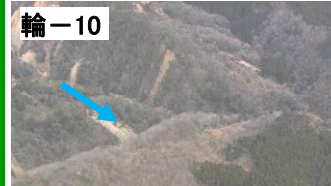
輪-10 【監視中】 ・大きな変状は認められない
