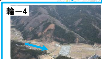
輪-4 鈴屋川(町野町鈴屋) 【応急対策済】 ・掘削により通水断面確保
