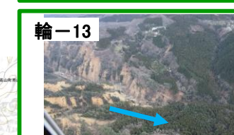
輪-13 鈴屋川[牛尾川](町野町寺山) 【監視中】 ・大きな変状は認められない
