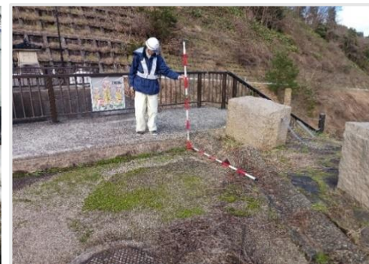
堤体の被災状況調査 (1.5石川県現地調査)
