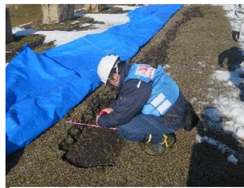
国総研による現地調査状況 (1.11現地調査)
