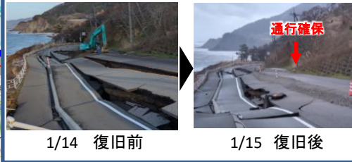
写真③ 国道249号緊急復旧完了
