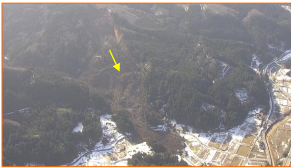
わじまし いちのせまち ②石川県輪島市市ノ瀬町
