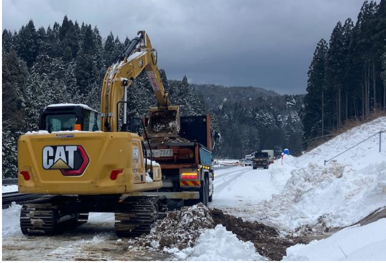
No.3 土砂積込運搬状況
