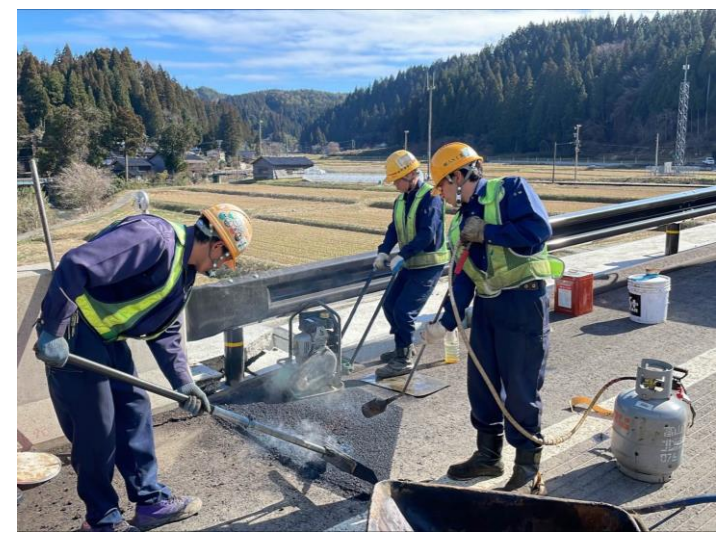
No.1付近 加熱合剤施工状況
