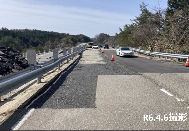
No.37付近 路盤完了状況
