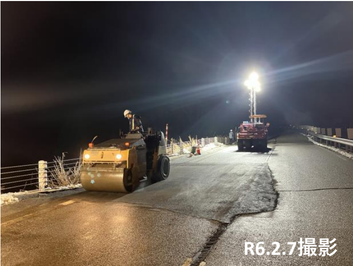
No.34付近 舗装状況
