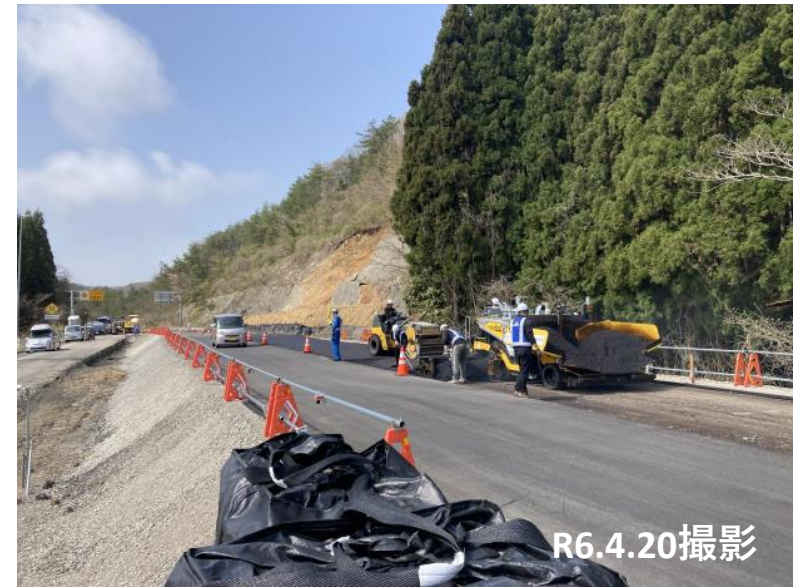
No.29付近 舗装状況
