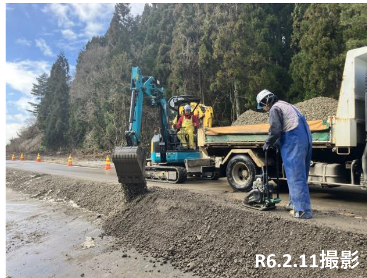
No.24付近 路肩路盤整備状況
