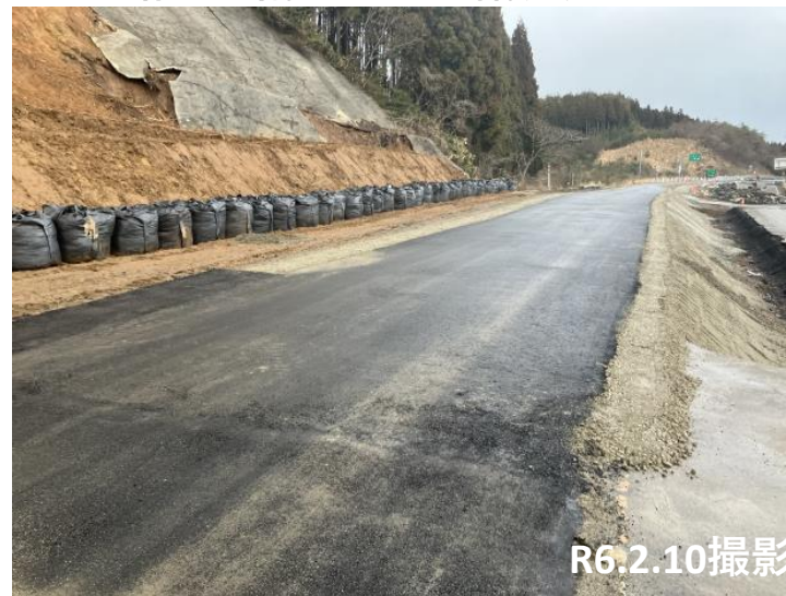
No.29 路盤整備およびAs舗装完了
