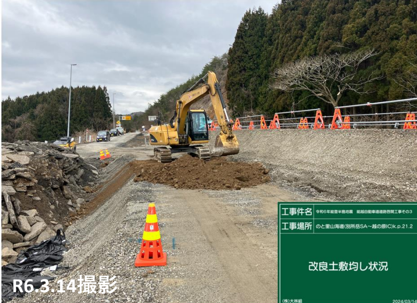
No.29 改良土敷き均し状況
