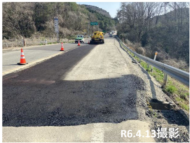
No.13付近 乳剤散布状況
