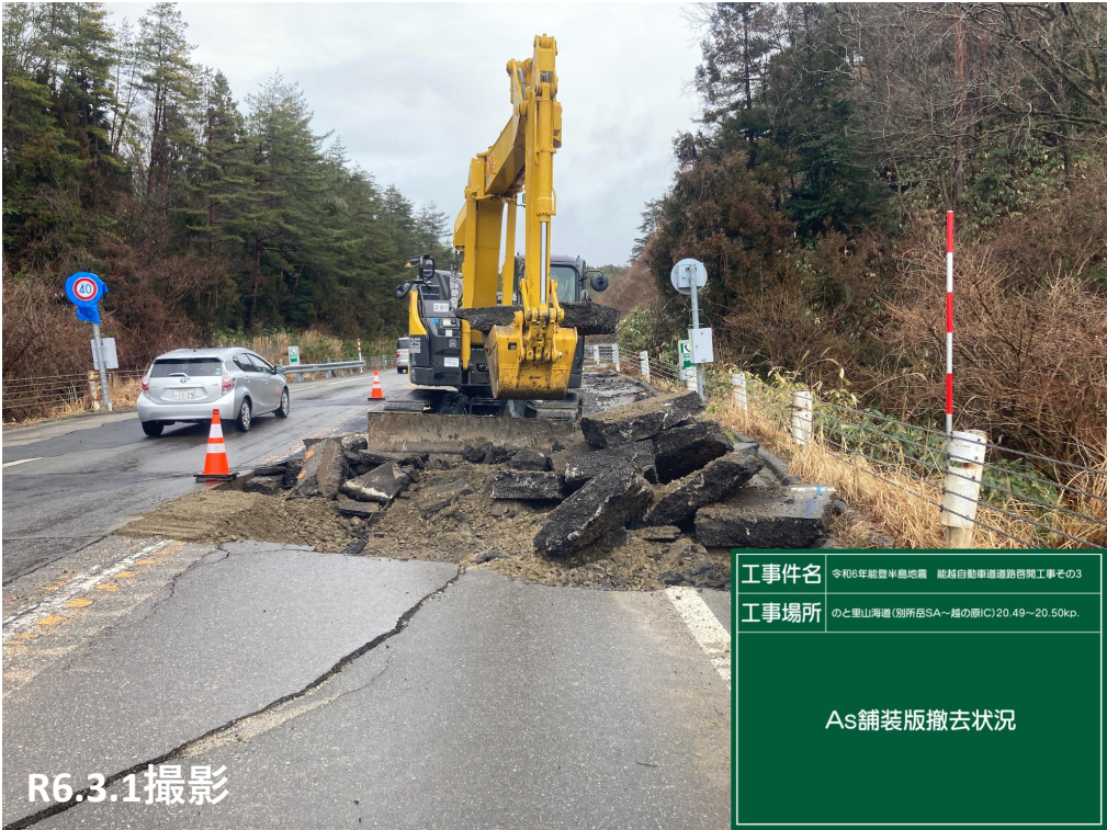
No.26付近 舗装撤去状況
