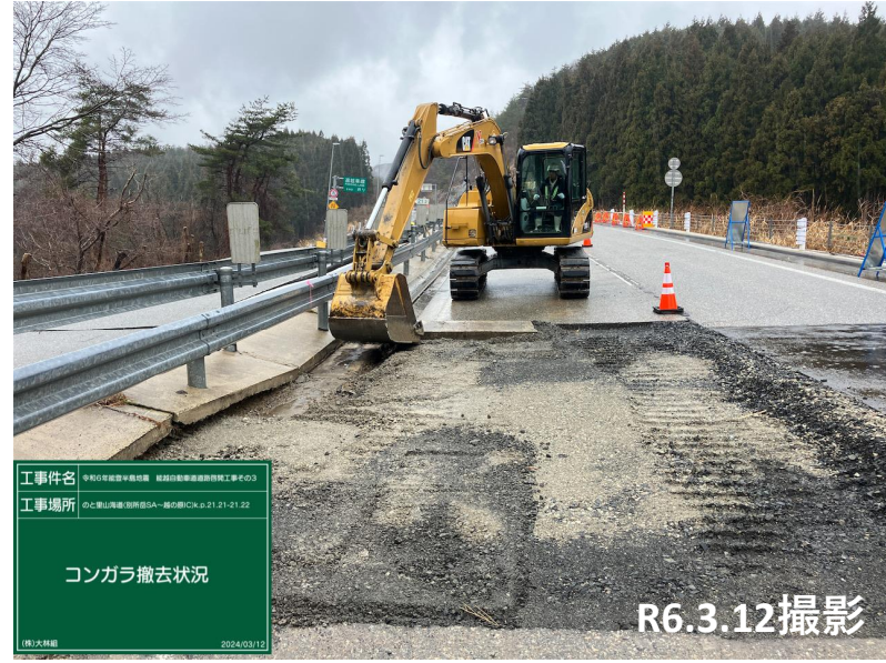
No.30付近 舗装撤去状況
