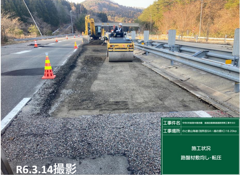
No.1 路盤材敷均し状況
