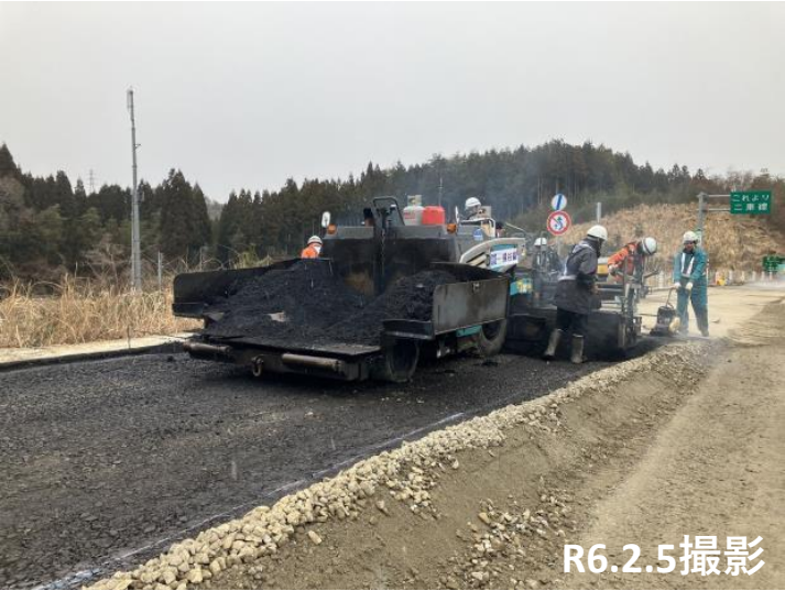
No.29～30付近 舗装施工状況
