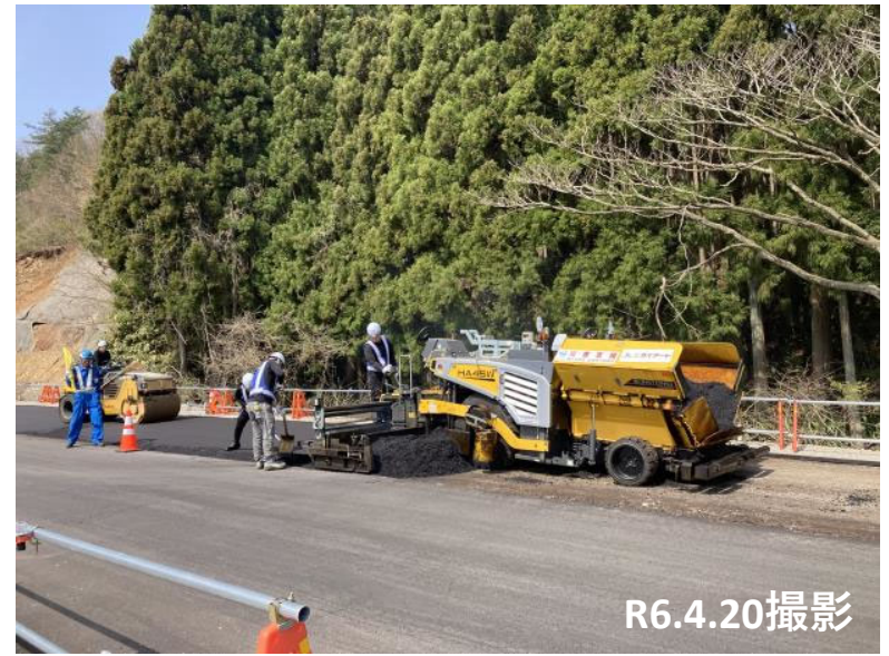
No.29付近 舗装状況
