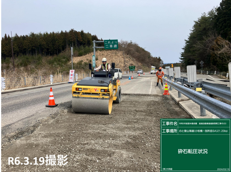
No.30 砕石敷均し・転圧状況
