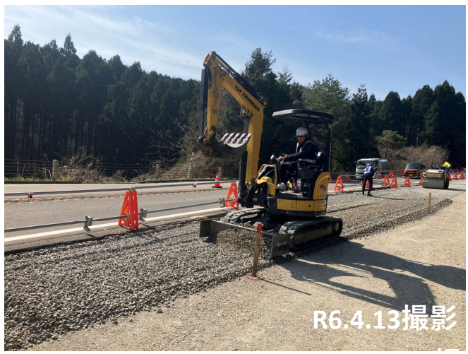
No.24付近 路盤工状況
