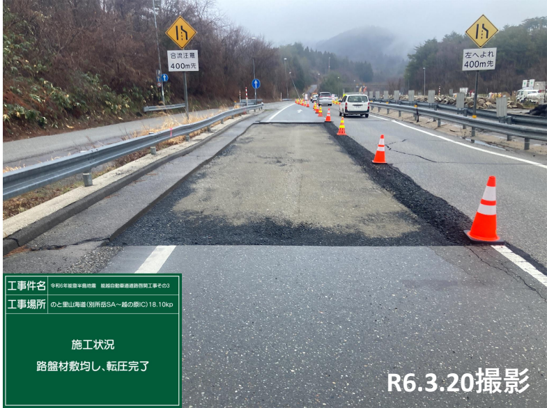
No.1 砕石敷均し・転圧状況
