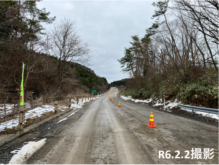
No.7付近 路盤施工状況
