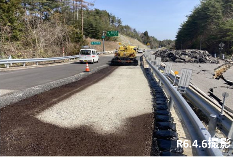
No.37付近 路盤完了状況
