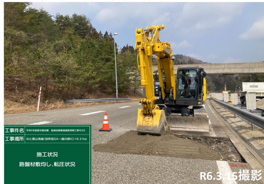
No.5路盤材敷均し、転圧状況
