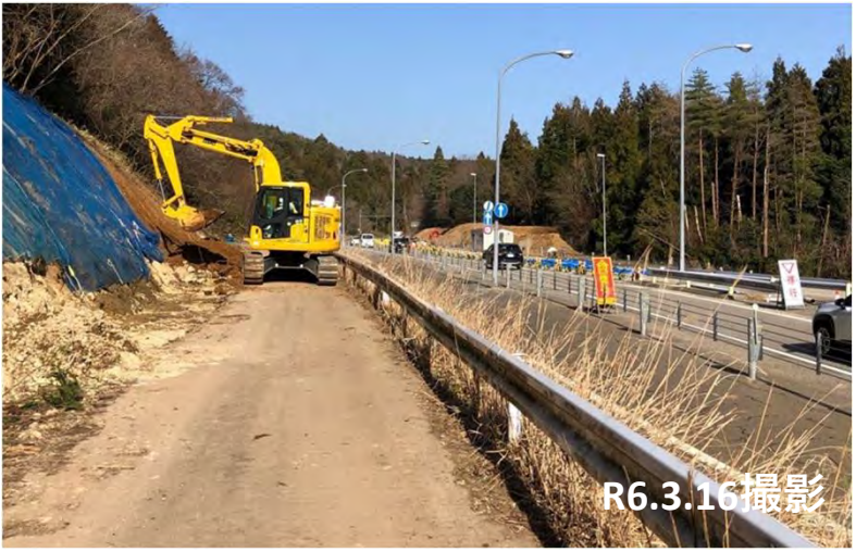
No.1付近 伐採作業状況
