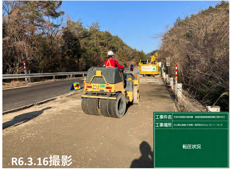
No.21 転圧状況
