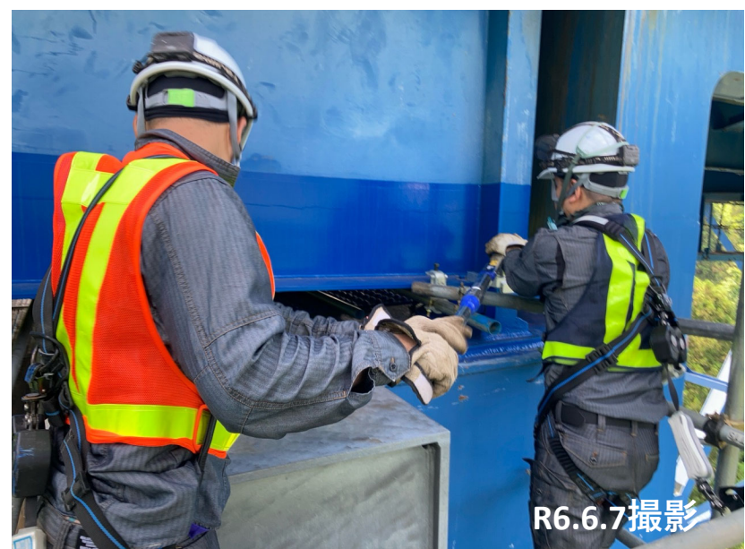
No.10 ピンチプレート交換状況
