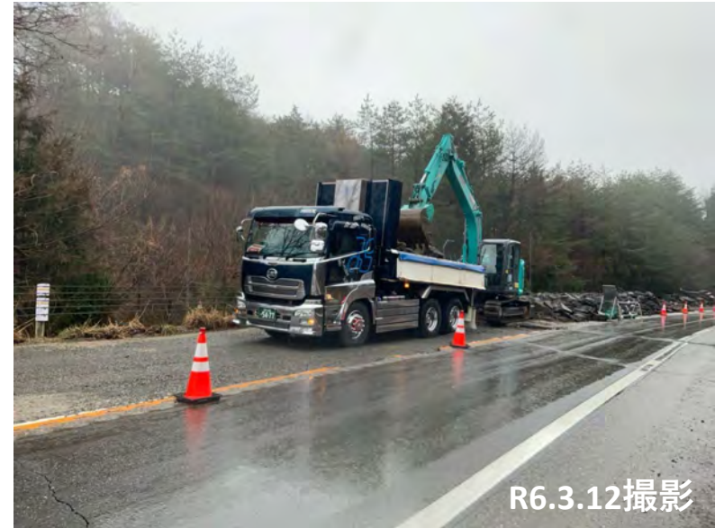
No.8 ガラ搬出状況
