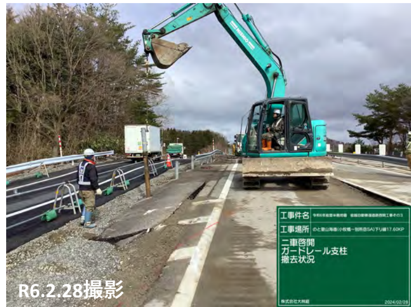
No.44 ガードレール支柱撤去状況
