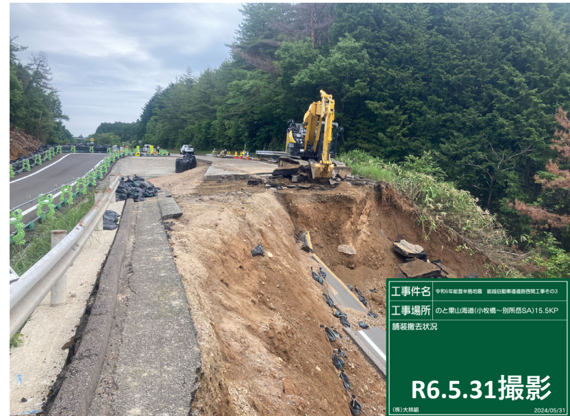
No.23付近 舗装撤去状況
