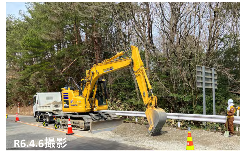
No.11 砕石敷均し状況
