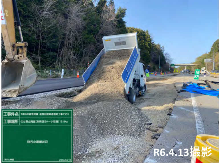
No.25付近 碎石小運搬状況
