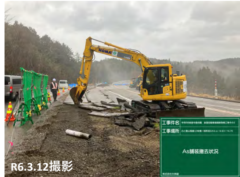
No.17 舗装撤去状況
