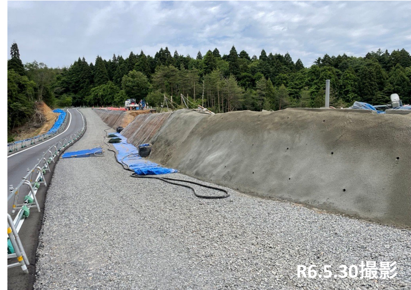
No.23付近 舗装撤去状況
