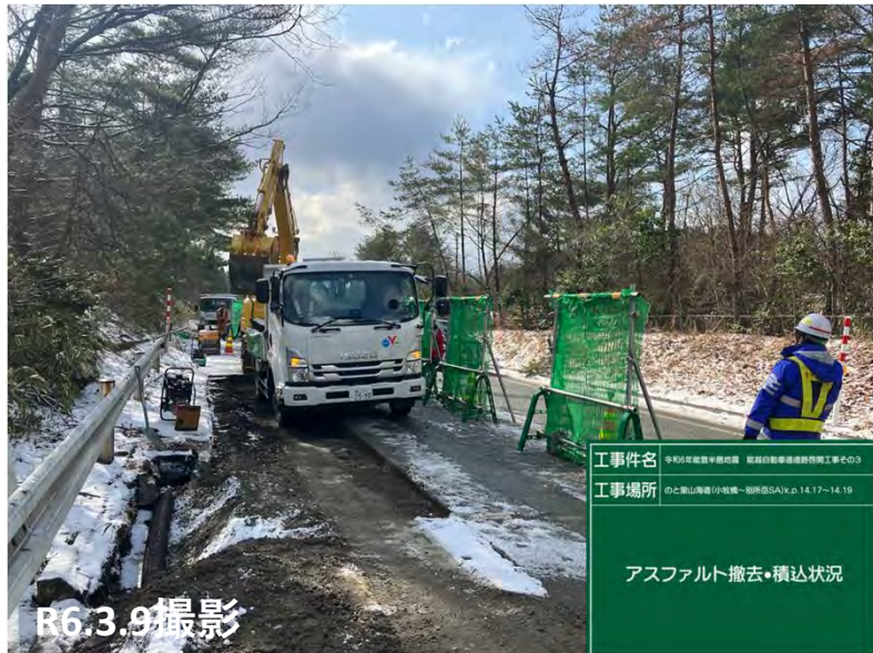
No.14 舗装撤去 積込運搬状況
