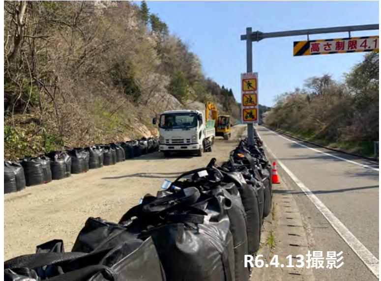
No.1付近 碎石敷均し状況
