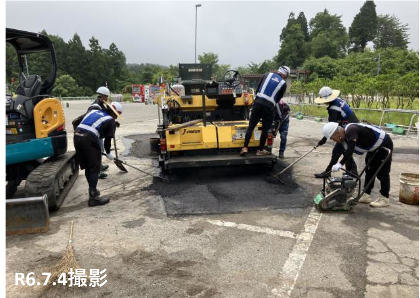
No.10 陥没部補修状況
