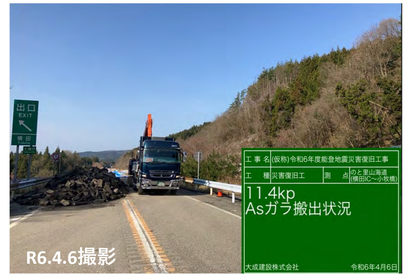
No.2 付近 アスファルトガラ積込搬出状況
