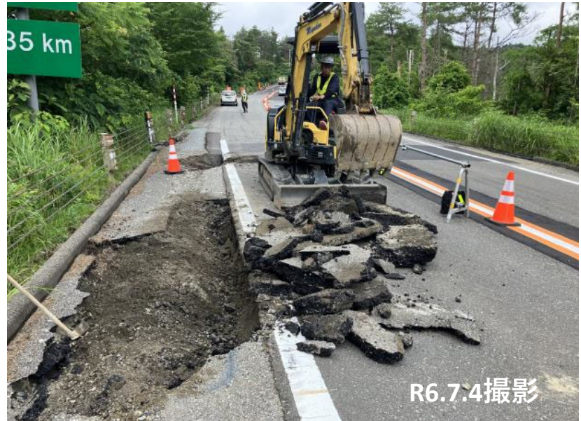
No.10 陥没部補修状況
