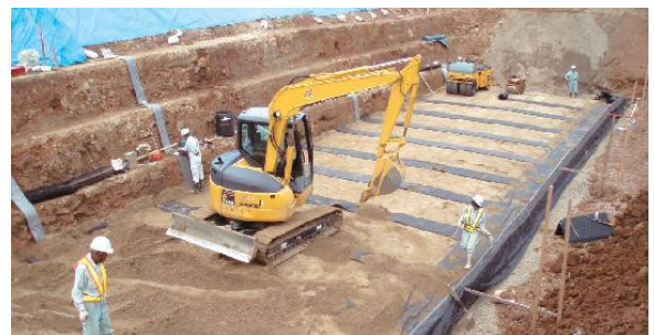
写真2. 水平排水材の敷設状況
