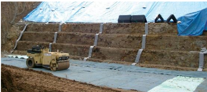
写真1. 段切り施工状況、補強材（ジオテキスタイル）・縦排水の敷設状況
