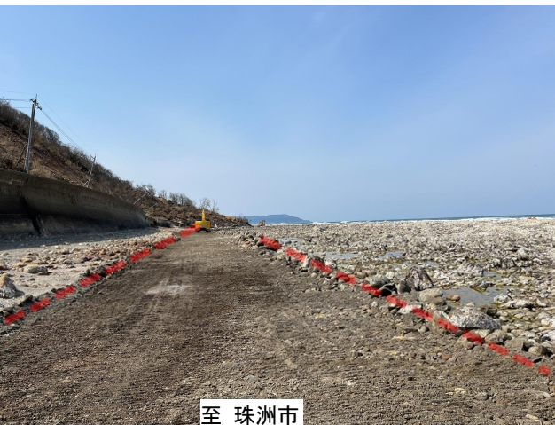
写真3. 海岸隆起部迂回路整備状況（珠洲市側）
