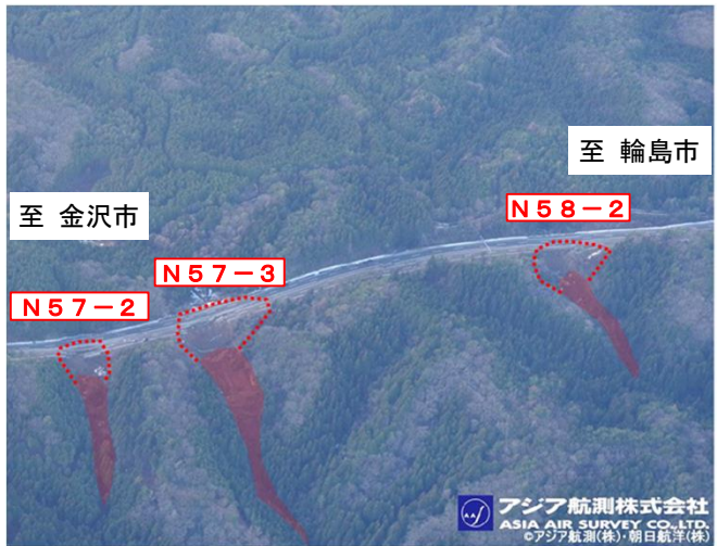
写真 2. 別所岳 S A 付近盛土崩壊状況
