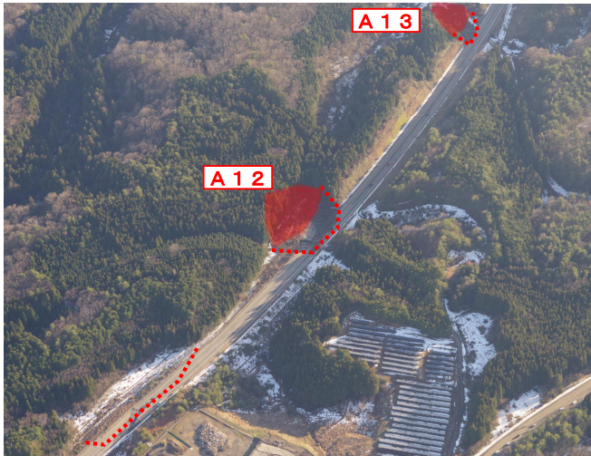
写真 1. のと里山空港 I C 付近盛土崩壊状況
