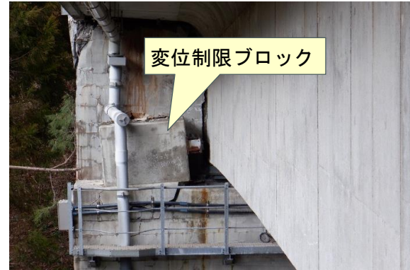
写真2. 桁の変位を拘束した変位制限ブロック
