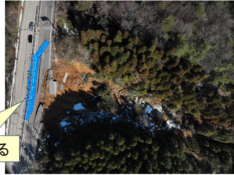
写真2. 4車線区間の盛土崩壊状況
