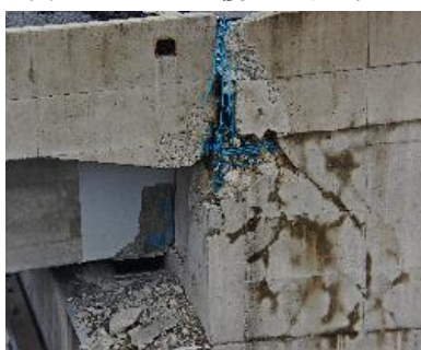
写真3. トンネル覆工崩落・変形（大谷トンネル）
