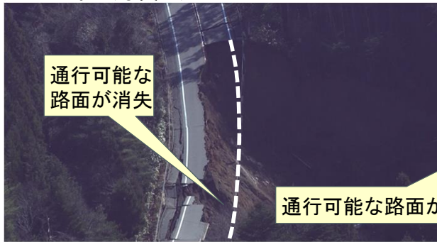
写真1. 2車線区間の盛土崩壊状況
