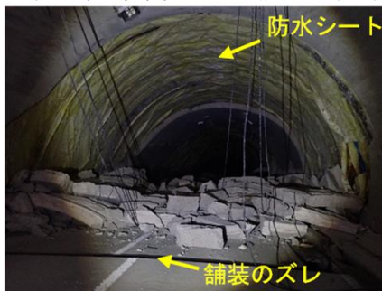
写真3. トンネル覆工崩落・変形（大谷トンネル）
