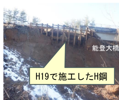
写真5. R6地震による能登大橋橋台背面の崩壊状況
