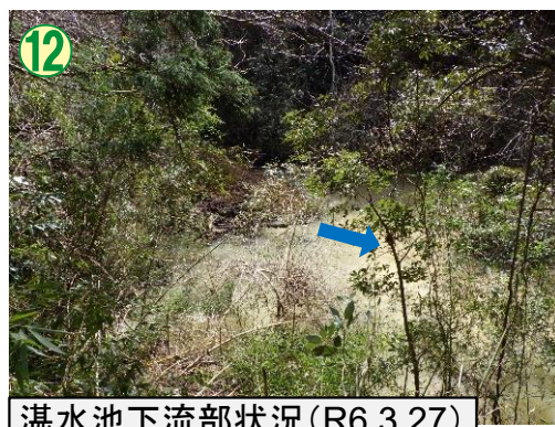
湛水池下流部状況(R6.3.27)
