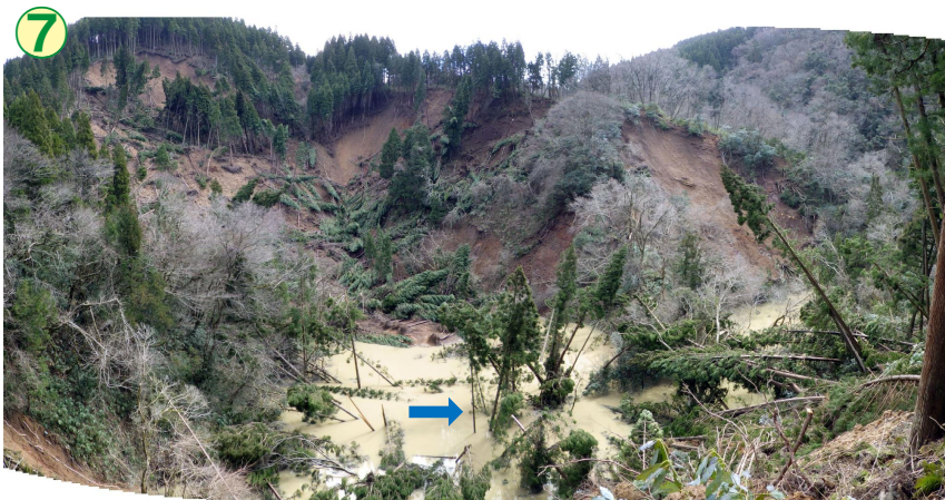
上流湛水池状況(R6.3.27)
