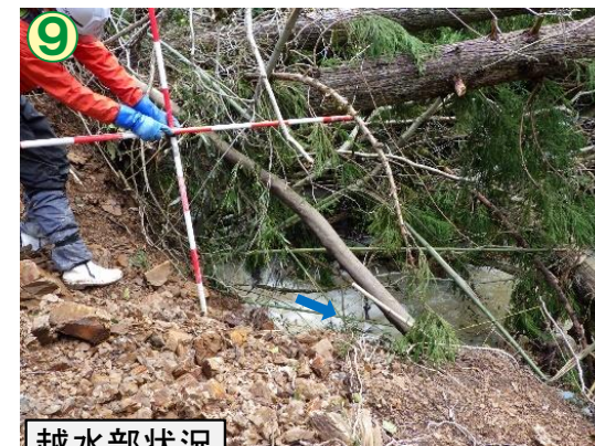
越水部状況 (R6.3.27)
