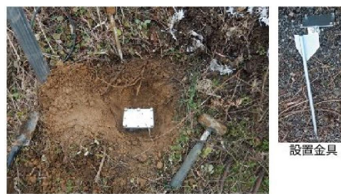
検出部設置場所に設置金具を打ち込んだところ
