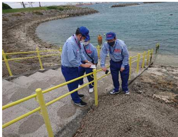
那覇港(泊ふ頭地区②) 現地調査
