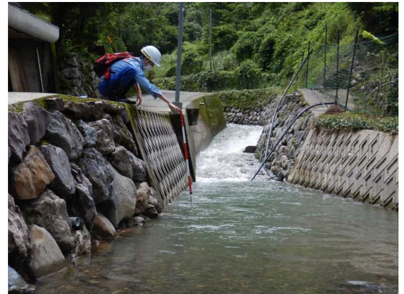
上原地先 溪流調査の状況
