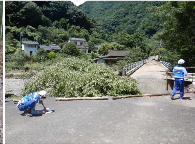
境目地先 現地状況 (アクセス路の状況確認)
