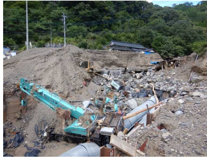
伊高瀬地先 現地状況 (土砂堆積状況)
