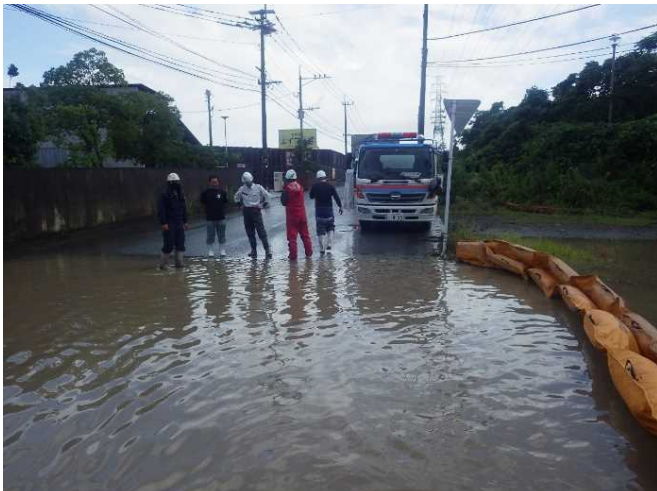
路面冠水状況現地確認 (大牟田市 新開地区)
