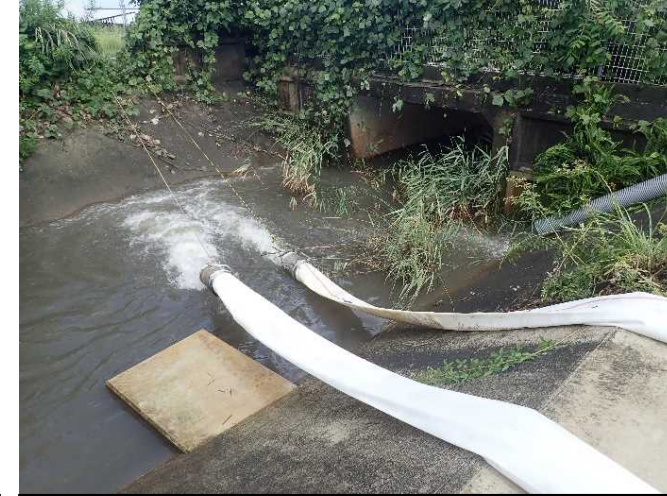
排水ポンプ車運転状況確認 (大牟田市 新開地区)
