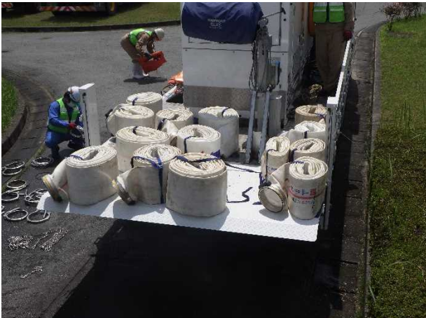
排水ポンプ車 引渡前準備 (南部浄化センター)
