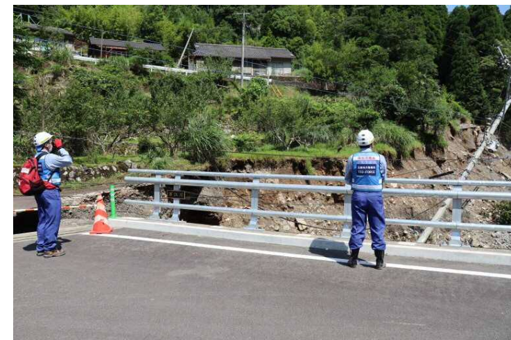
①大川内橋上部落線 現地調査
