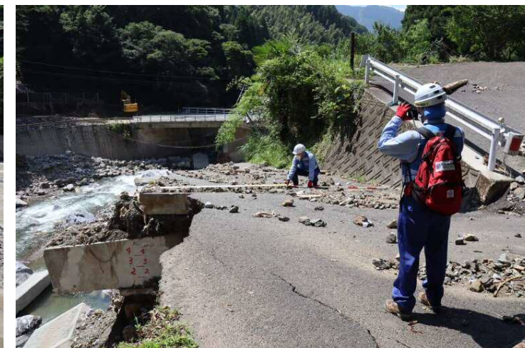
①大川内橋上部落線 現地調査
