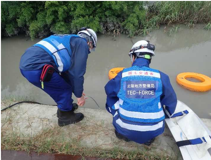
①南百姓樋管(状況確認)
