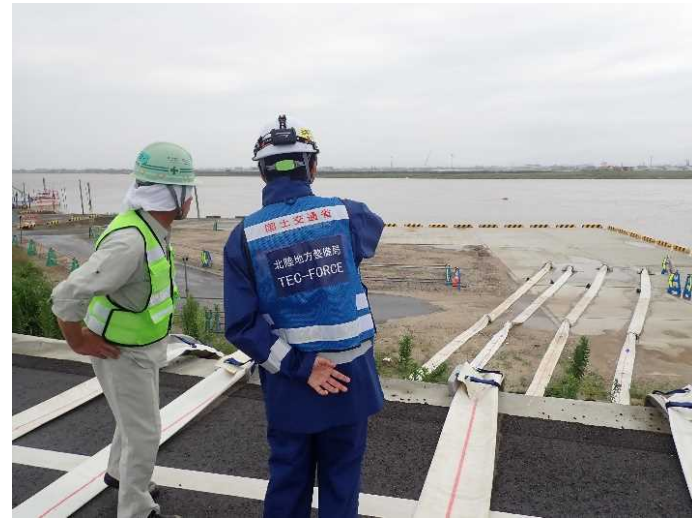
②南百姓樋管(排水ポンプ設置状況確認)
