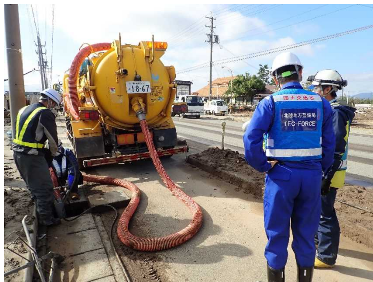
側溝清掃（国道18号 長野市大字穂保～赤沼）
