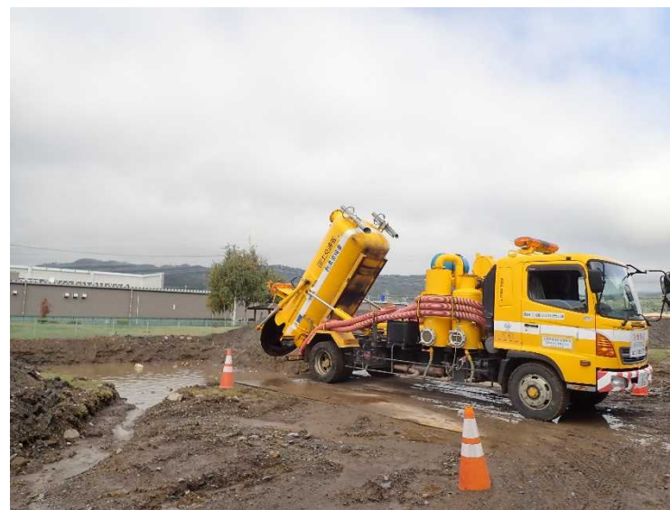
側溝清掃（国道18号 長野市大字赤沼）
