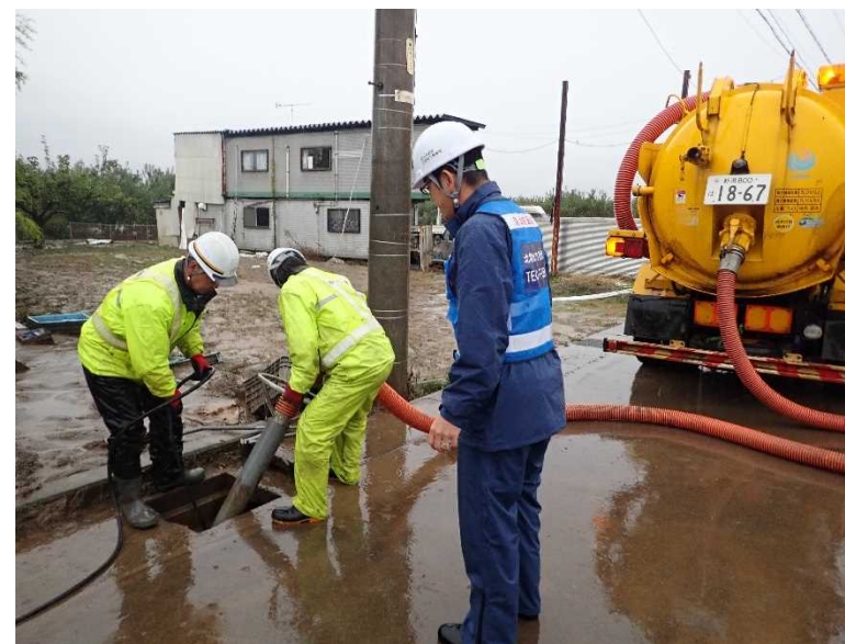
側溝清掃（国道18号 長野市大字赤沼） 土砂をジェット水流でかき出し、バキューム
