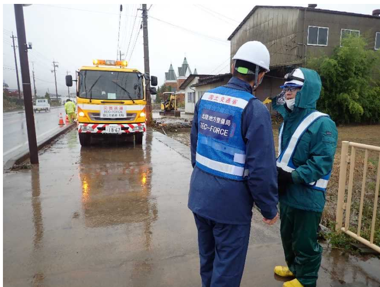
側溝清掃箇所の調整（国道18号 長野市大字赤沼）
