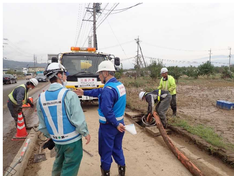
側溝清掃（国道18号 長野市大字赤沼）
