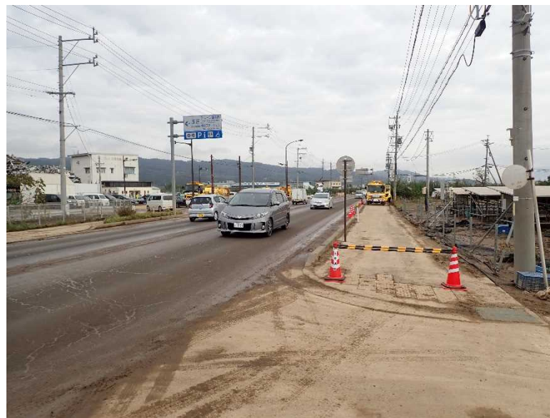
歩道上での作業状況（国道18号 長野市大字赤沼）
