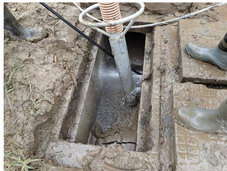
側溝清掃（国道18号 長野市大字赤沼） 土砂をジェット水流でかき出し、バキューム
