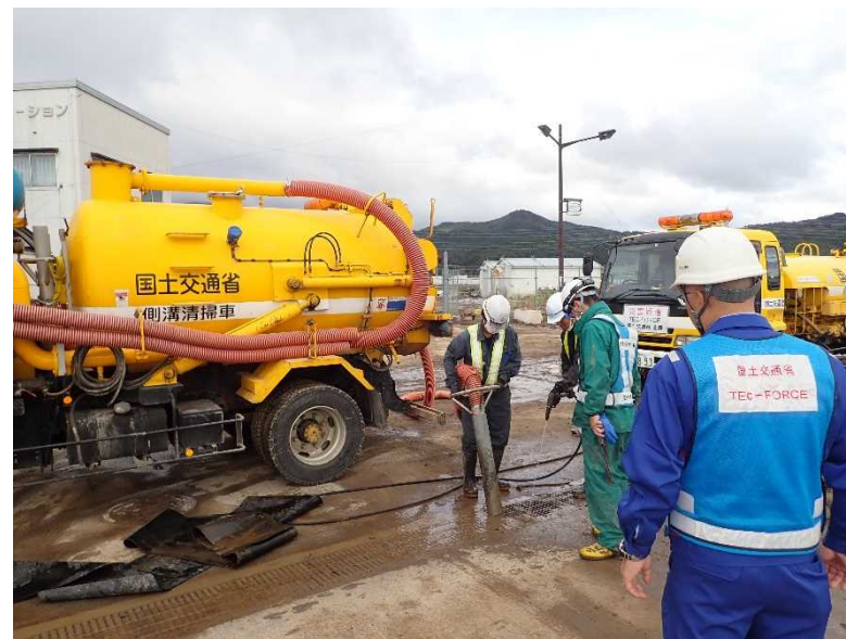
側溝清掃（国道18号 赤沼除雪ステーション）
