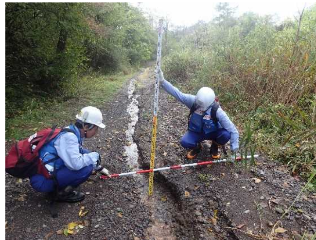
▲現地調査(上田市真田町地先_大柏木沢)[砂防第1班(松本)]
