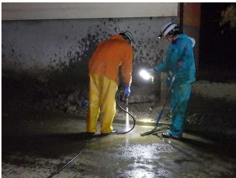
側溝清掃 (県道368号 村山豊野停車場線)
