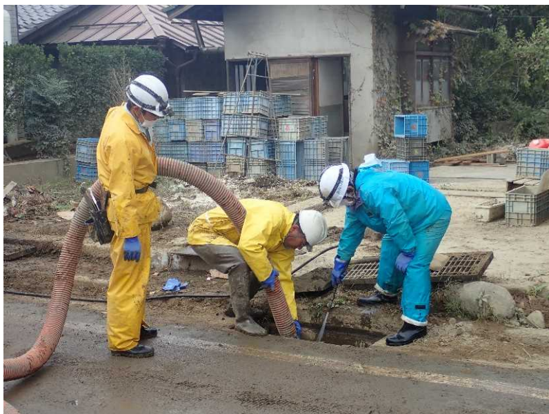
側溝清掃 (県道368号 村山豊野停車場線)
