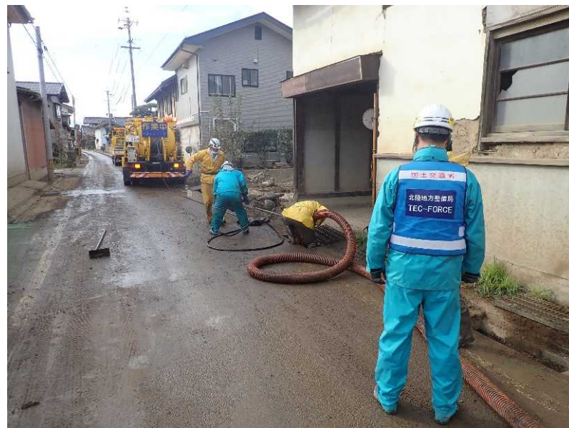
側溝清掃 (県道368号 村山豊野停車場線)
