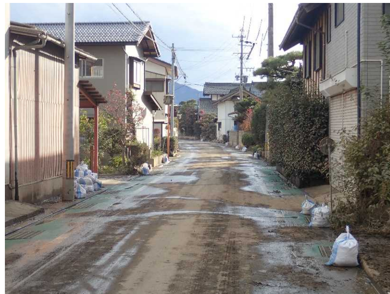
側溝清掃 (県道368号 村山豊野停車場線) 赤沼地区作業完了
