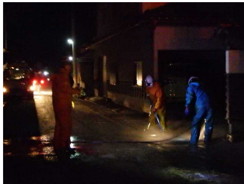
側溝清掃 (県道368号 村山豊野停車場線)
