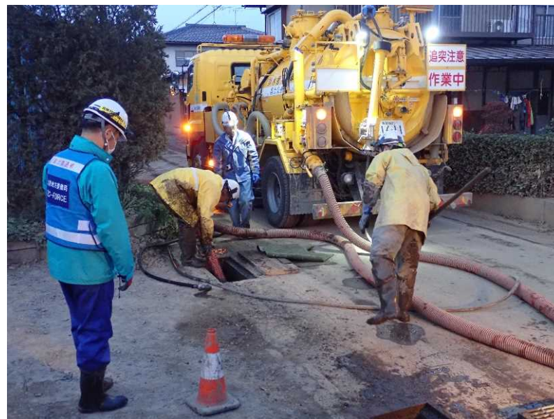
側溝清掃 (県道368号 村山豊野停車場線)
