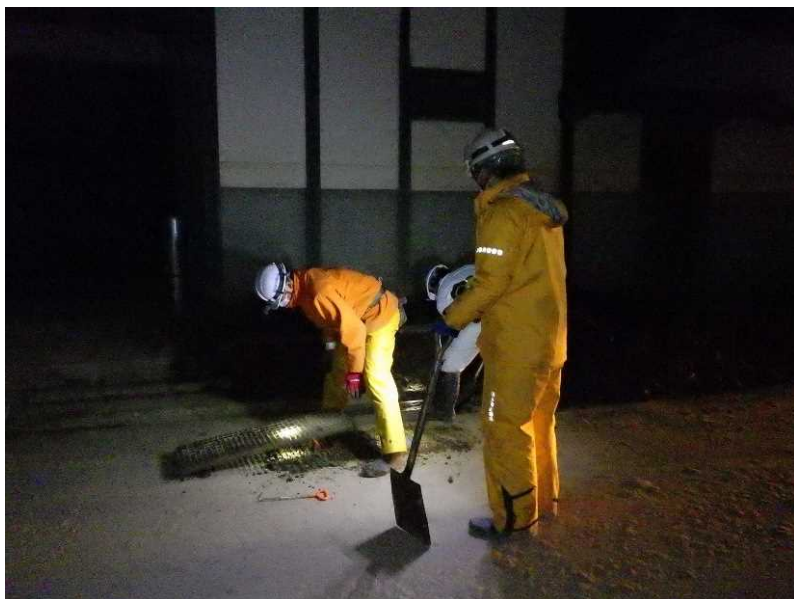
側溝清掃 (県道368号 村山豊野停車場線)
