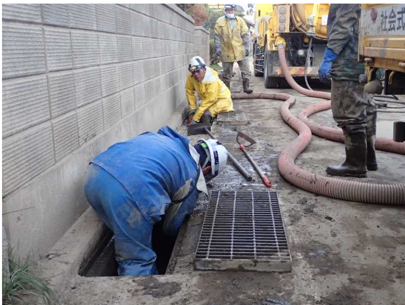
側溝清掃 (県道368号 村山豊野停車場線)
