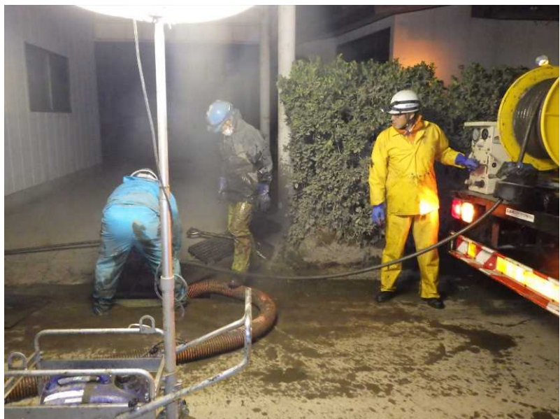
側溝清掃 (県道368号 村山豊野停車場線)
