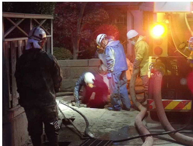
側溝清掃 (県道368号 村山豊野停車場線)
