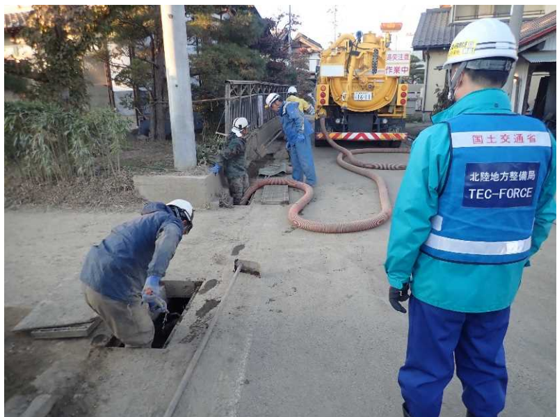
側溝清掃 (県道368号 村山豊野停車場線)
