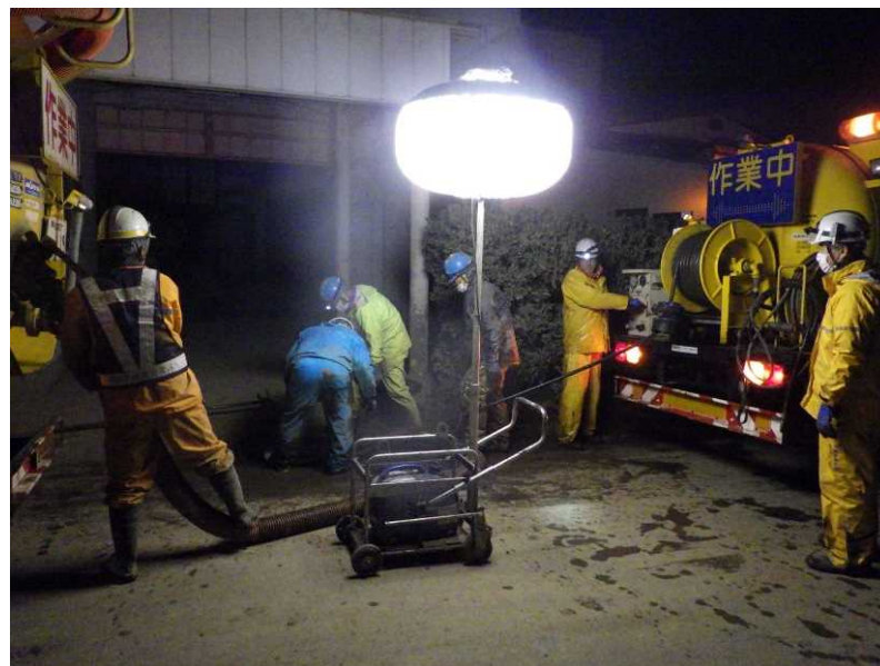
側溝清掃 (県道368号 村山豊野停車場線)
