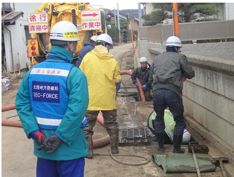
側溝清掃 (県道368号 村山豊野停車場線)
