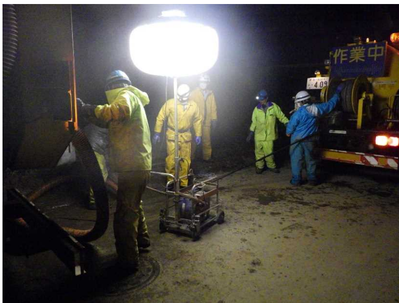
側溝清掃 (県道368号 村山豊野停車場線)
