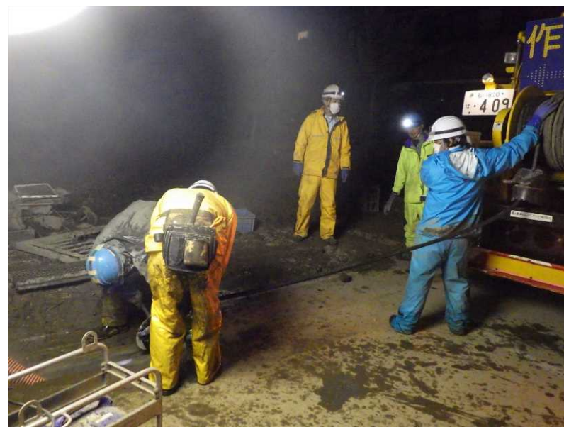
側溝清掃 (県道368号 村山豊野停車場線)
