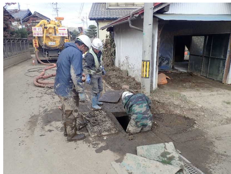
側溝清掃 (県道368号 村山豊野停車場線)
