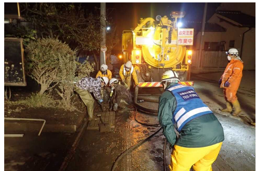
側溝清掃状況 (県道368号村山豊野停車場線)
