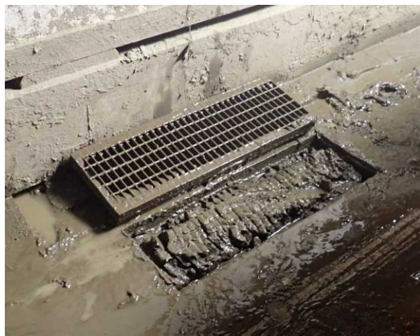
側溝堆積状況 (県道368号村山豊野停車場線)
