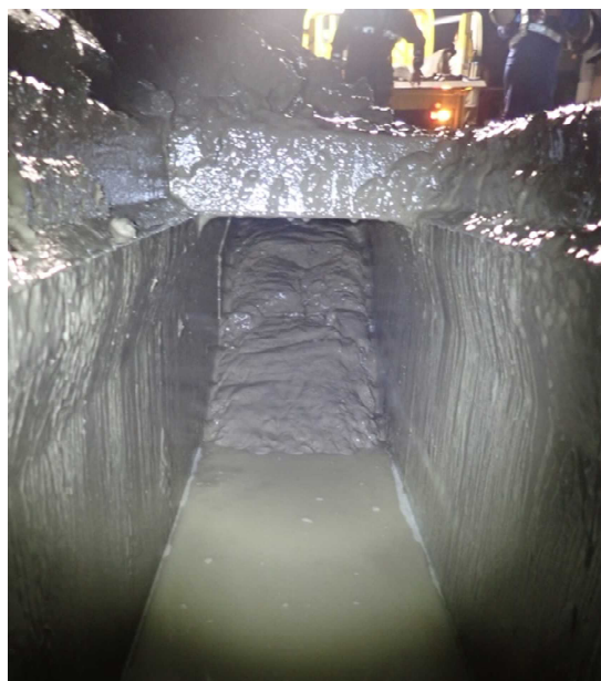
側溝堆積状況 (県道368号村山豊野停車場線)
