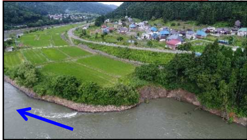
【千曲川：護岸崩壊】 長野県 野沢温泉村 七ヶ巻 地先
