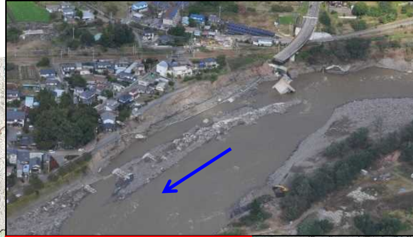
【千曲川：護岸崩壊・橋梁被災】 長野県 東御市 海野 地先～田中 地先
