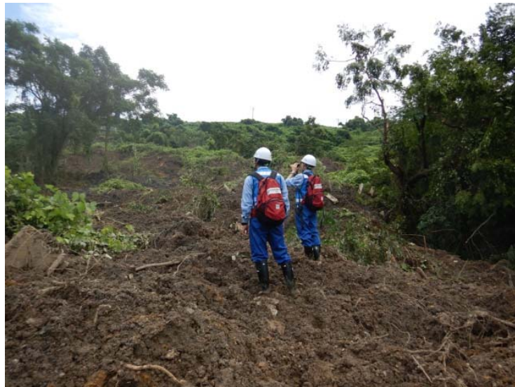
8月31日 沖の神川 河岸崩落状況 (佐賀県杵島郡大町町)
