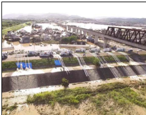
岡山県倉敷市真備町 緊急排水
