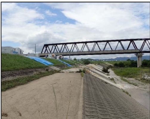
岡山県倉敷市真備町 緊急排水
