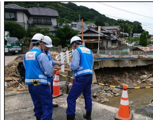
広島県坂町 被災状況調査(道路)
