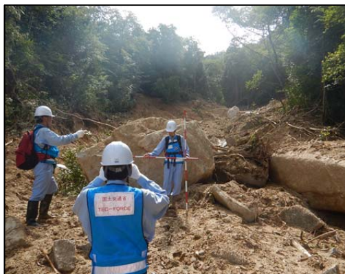
広島県広島市 被災状況調査(砂防)
