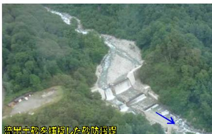
流出土砂を捕捉した砂防堰堤
