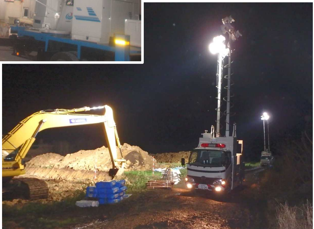
作業現場を照らす照明車（関川村）
